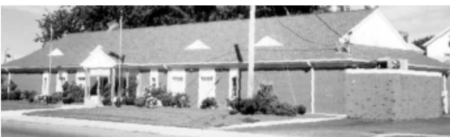
O edifício do Centro Cultural de Santa Maria
